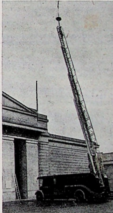
B.B.C. Televisiedienst. Gecombineerde antenne-, zender- en generatorwagen voor Televisieuitzendingen uit de buitenlucht
